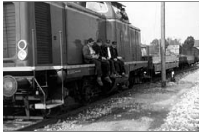
Bauzug mit V 100 in Diebach-Insingen etwa um 1965.
