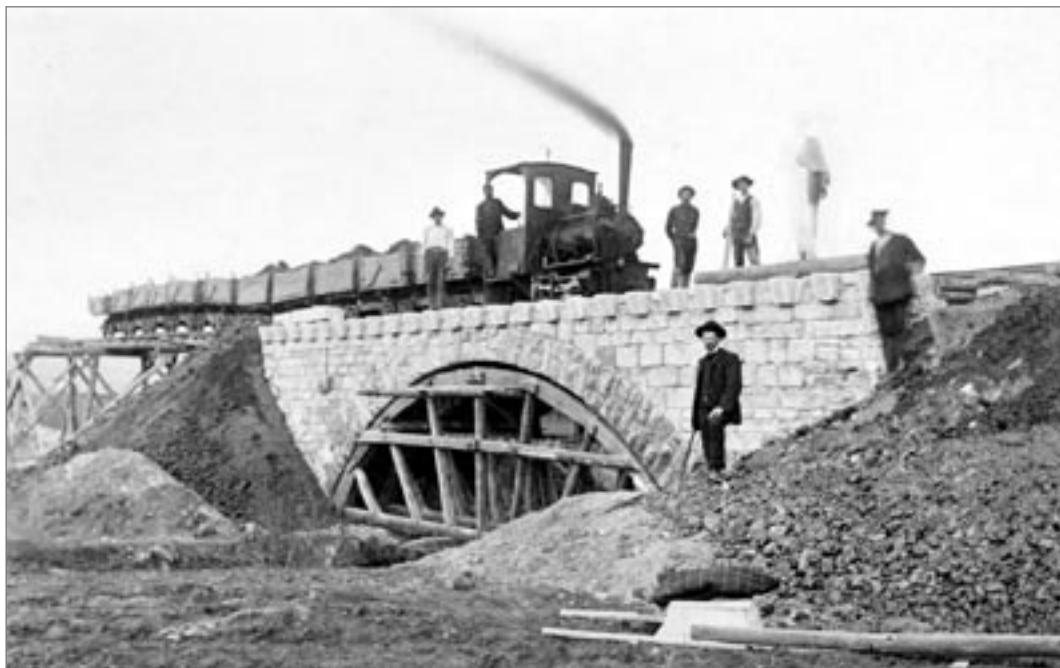
Aufnahme vom Bau von Brücke und Bahndamm zwischen Dombühl und Rothenburg mit Feldbahn und Muskelkraft. Quelle: Sammlung Lieb
