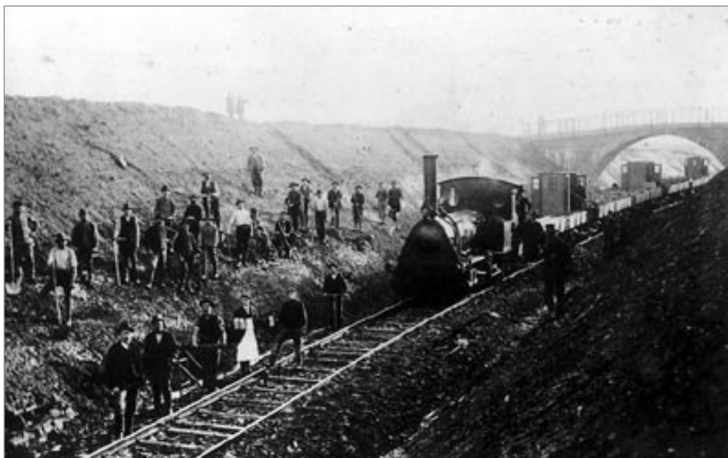
Bauzug bei der Diebacher Straßenüberbrücke – die Brücke überspannt noch heute einen verfüllten Einschnitt. Quelle: Sammlung Felker
