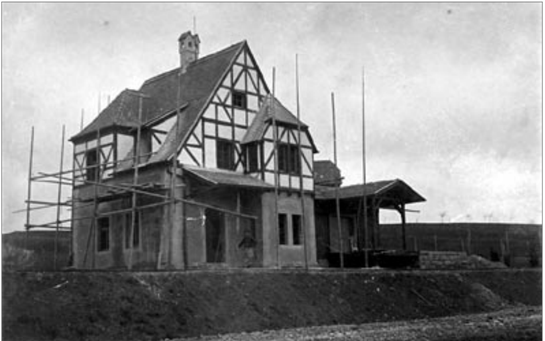
Bau des Diebacher Bahnhofs in landschaftstypischer Bauweise in Naturstein und Fachwerk mit einem Güterschuppenanbau aus Holz. Quelle: Sammlung Lieb
